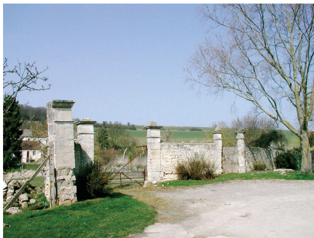
Piliers du porche d'entrée de l'ancien moulin de Buchet
