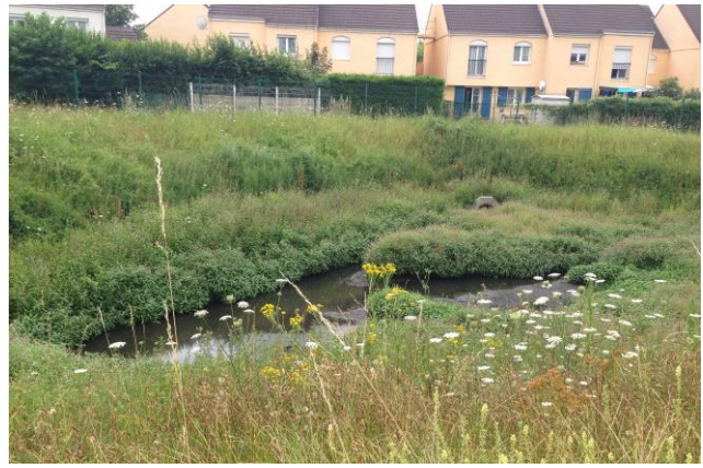
Bassin de rétention rue François Villon
