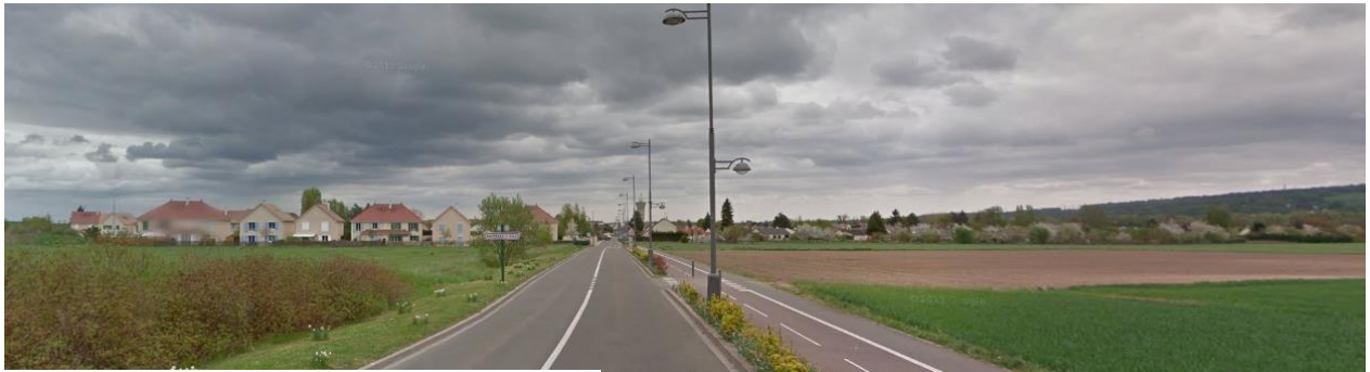
Entrée de ville Ouest le long de la RD924z
