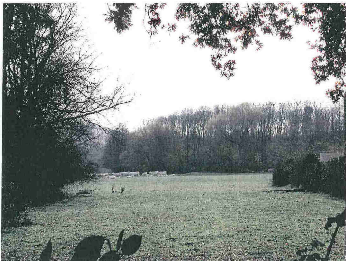
Station d'épuration existante
