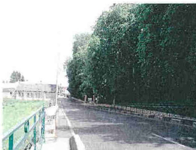
Pont de Runneval
