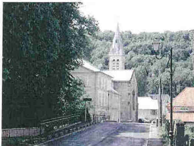
Grande rue - Pont de Runneval - Eglise
