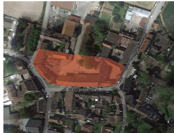
Ensemble de constructions : ancien corps de ferme
