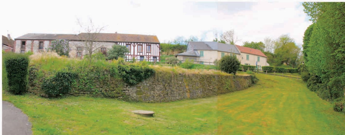
Vue du secteur sud depuis l'impasse du Sausset
