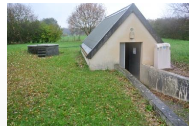
Station de production de Berville
