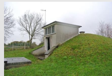
Réservoir de Berville
