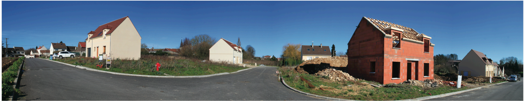
Vue depuis la rue de la Vigne
