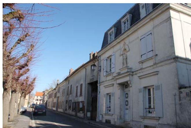
Alignement bâti rue Faubert
