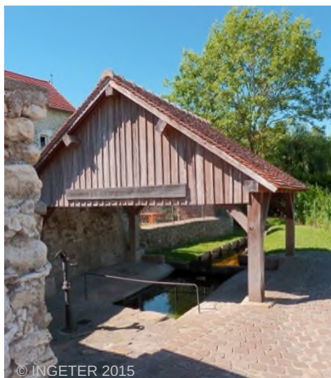
Figure 86: Le lavoir en 1990 gauche), et en 2015 après restauration (à droite)
