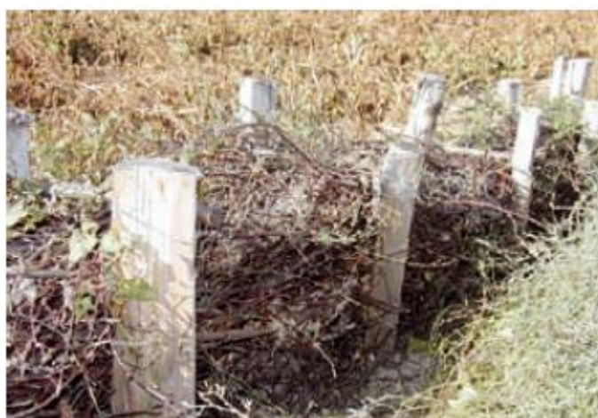
Figure 5.15 : Exemple de fascine en bois mort
