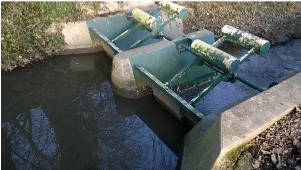
Figure 1.3 : Photographie de la vanne à l'entrée du canal de décharge
