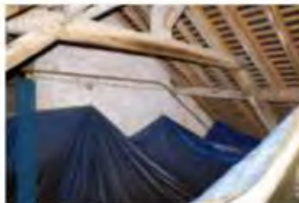
Bâches de protection dans un couloir
