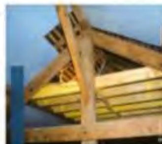
Installation d'un plancher
