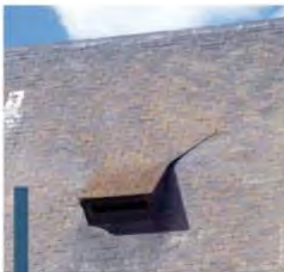
Chiroptière sur le toit d'une église
