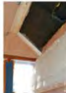
Construction d'un caisson isolé
