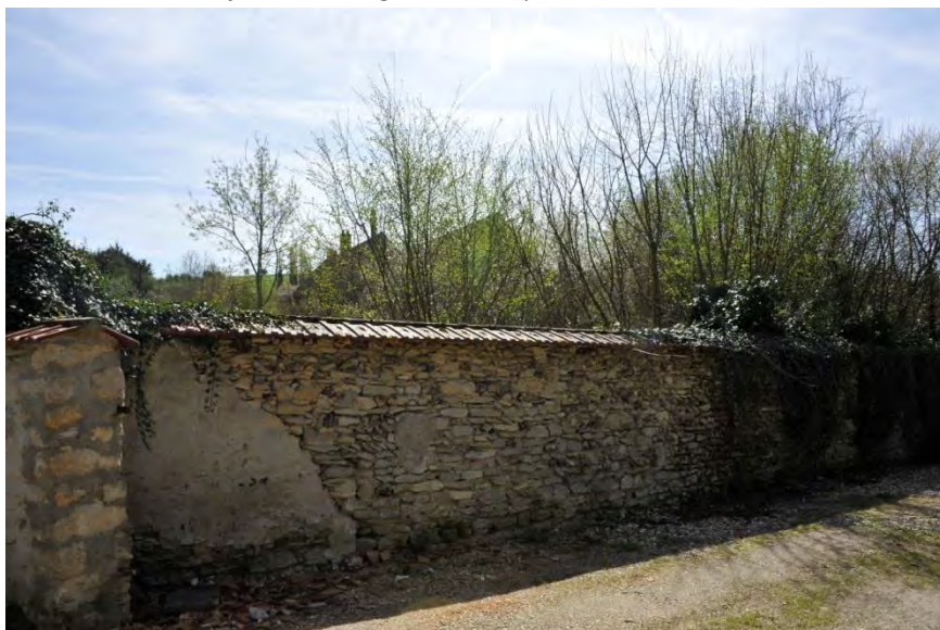
Mur coté ruelle de l'Abreuvoir
