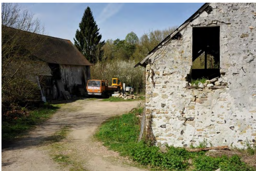
Parcelle 467, cour de ferme et sa végétation nitrophile linéaire aux abords des bâtiments
