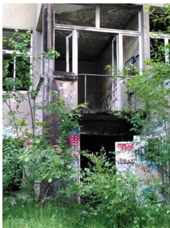
Façade Nord du bâtiment B (Porte 61) - Ecosphère
