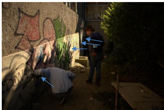
Façade Nord du bâtiment B (soulpiraux 48 à 50 et Porte 60) - Ecosphère
