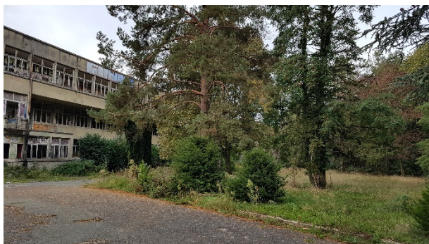
Emplacement du parking en façade nord – Ecosphère
