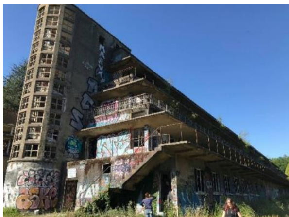
Angle Sud-Ouest du bâtiment B- Ecosphère
