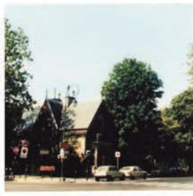
ENTRÉE DE NEUILLY PORTE DES BARBONS, VUE VERS LE BOIS (PAVILLON DE GARDE)
