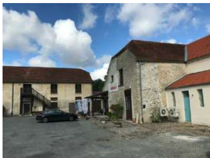
Architecture de la Ferme de la Grange
