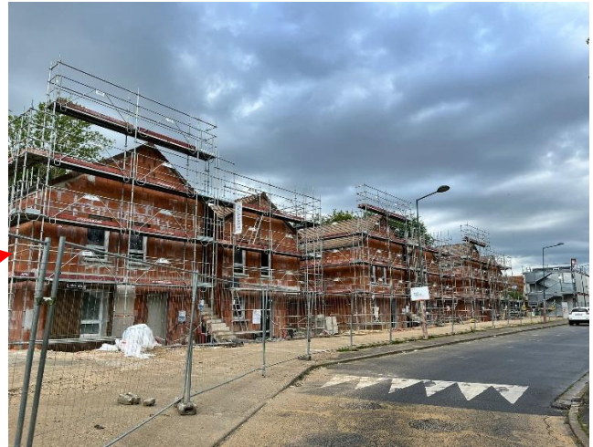
Photo 4 – Les 9 logements groupés en construction rue Antoine de St-Exupéry. Atelier TEL 2024.
