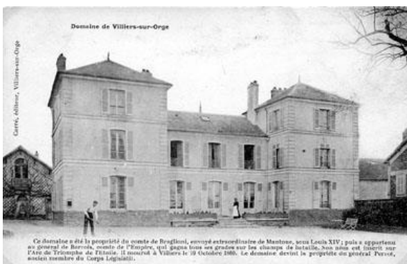
Le chateau démoli de la Résidence du Parc
