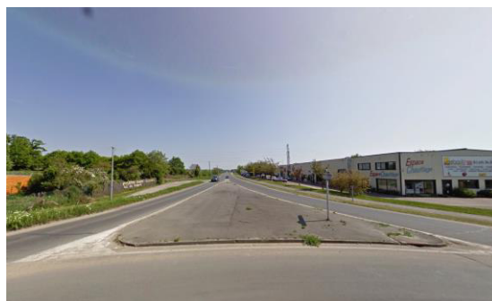
Entrée de ville depuis la route de Chasse
