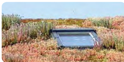
UNE TOITURE QUI VARIE SELON LES SAISONS
