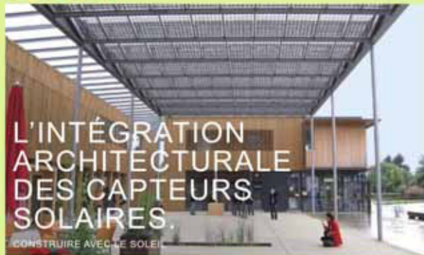
Un plan de capteur photovoltaïque intégré au plan d'urbanisme. Lucien Courtey, Architecture d'IDRAC, 78
