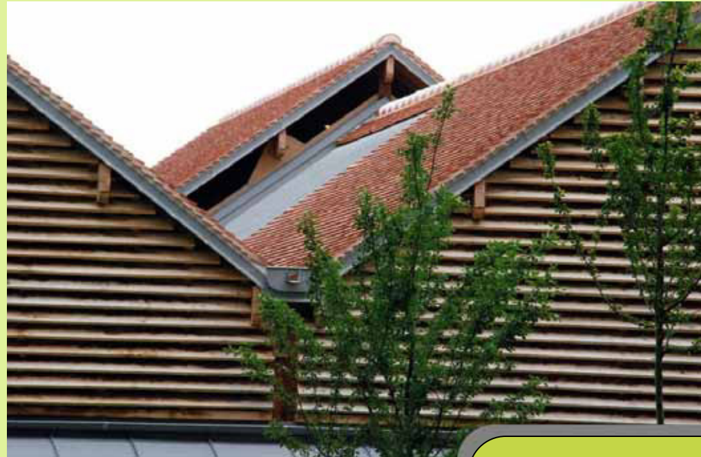
Capteurs entre deux toits
