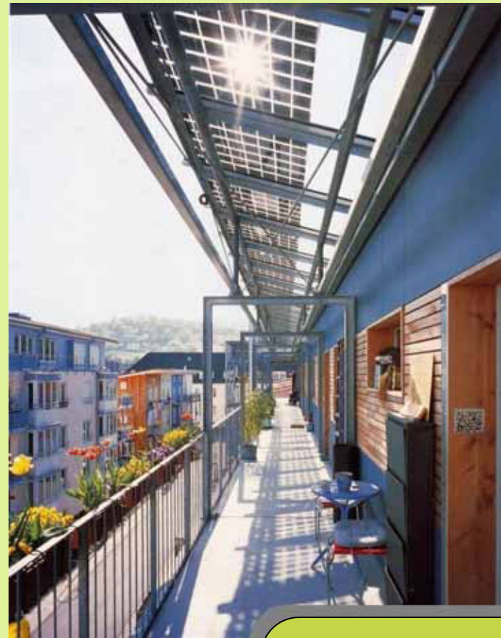
Coursive de logements
