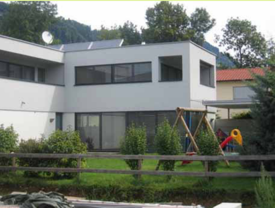
Capteurs en toiture terrasse (Maison dans le Vorarlberg)
