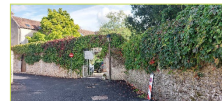
Végétalisation des murs
