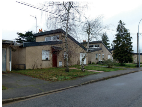
Châteaudun Maisons accolées Densité 15 log/ha
