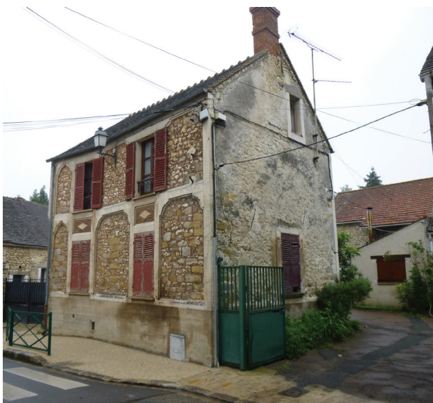
Maison de bourg, sur la rue de la Croix Bussière
