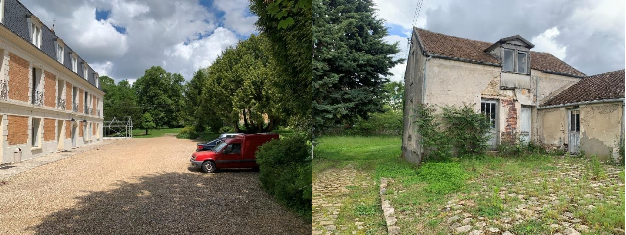
Figure 10 : Vue sur quelques bâtiments de l'aire d'étude
