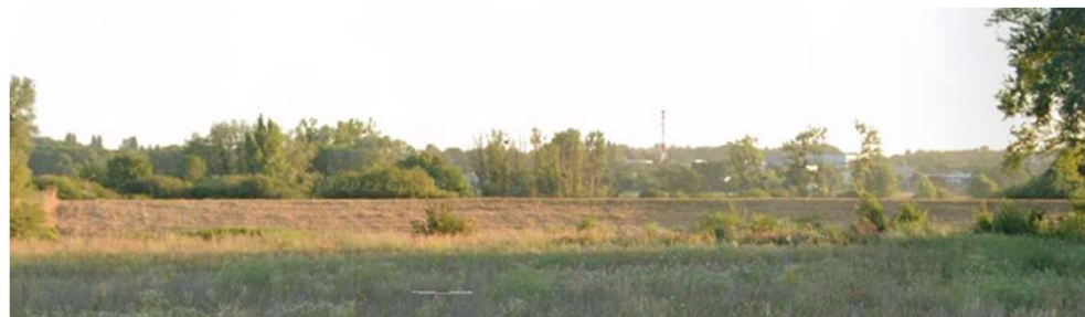
Digue (source : Google Street View, juill. 2022)
