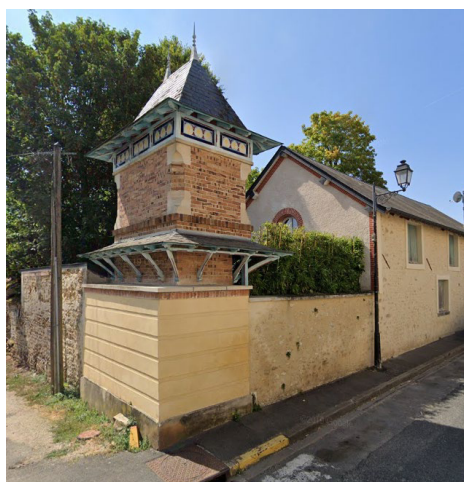
Maison de notable au 43, rue des noblets
