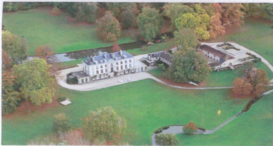
Les Bâtiments: La façade ouest du Château (où vous apercevez le rez de jardin) A droite : la chapelle puis les annexes encadrant la cour, l'orangerie et sa terrasse
