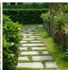
Pavés à joints enherbés
