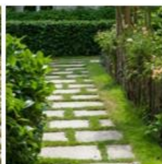
Pavés à joints enherbés
