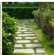
Pavés à joints enherbés
