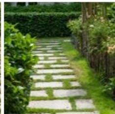
Pavés à joints enherbés
