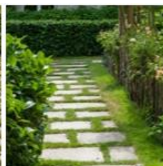
Pavés à joints enherbés
