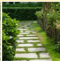
Pavés à joints enherbés
