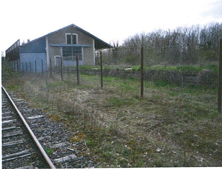
Le terrain borde une voie de chemin de fer désaffectée
