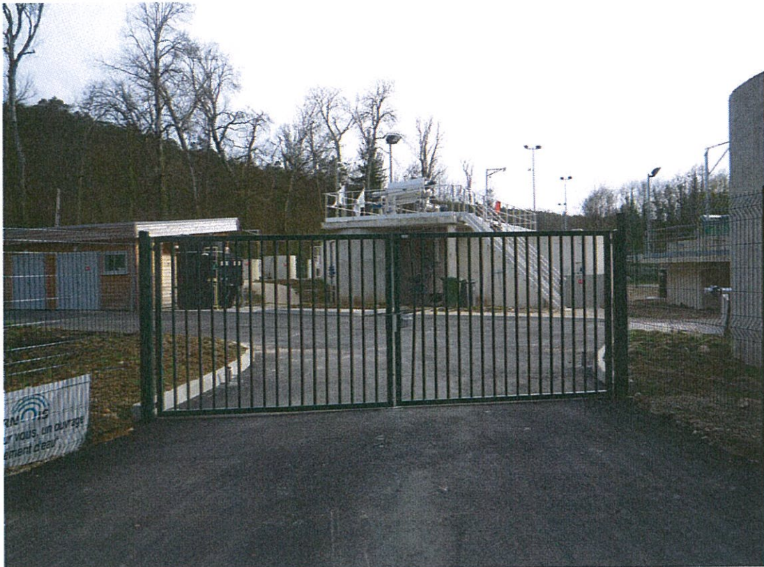
La station d'épuration
