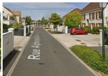
Rue Alphonse Daudet (Val d'Albian) Travail de la matérialité pour alléger la présence de la voirie et intégrer le végétal
