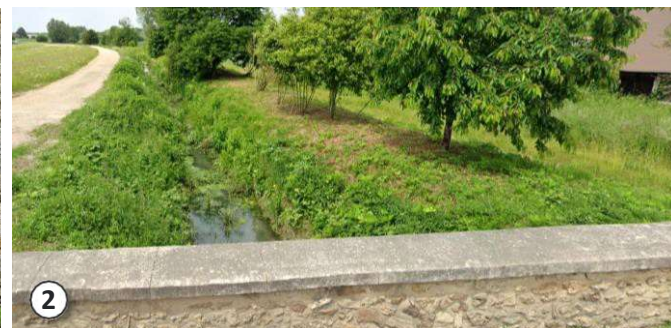
2 Les rigoles et leurs ponts en pierres
