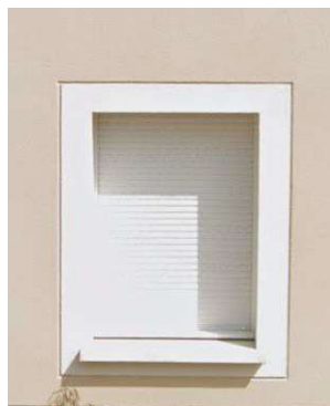
Volet roulant intégré et encadrement de fenêtre en façade
