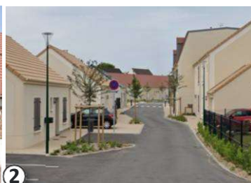
Rue des Hospitaliers Décroché de voirie favorisant le ralentissement, intégrant le stationnement et la végétation dans le paysage urbain
