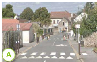
Dos d'âne et resserrement de voirie à proximité des équipements
