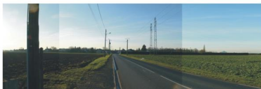
Entrée Est: RD 18 Route de Monnerville
