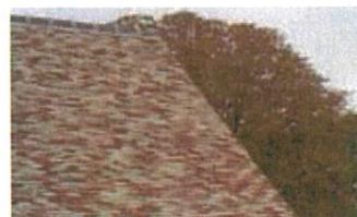
Toiture chamarrée par le mélange des tuiles
