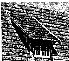
Lucarnes rampantes (chien couché)
