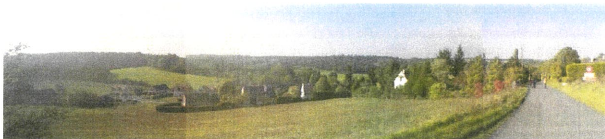
Entrée de ville depuis la route de Mézières (Source : IngESPACES)
