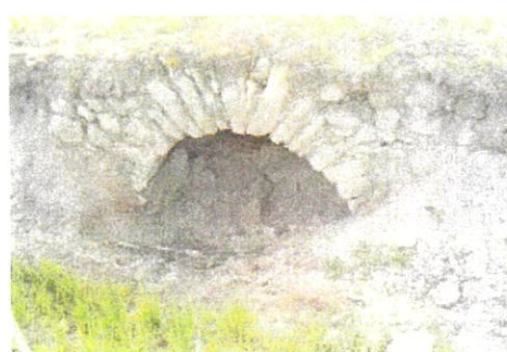
Ancien ouvrage remblayé
