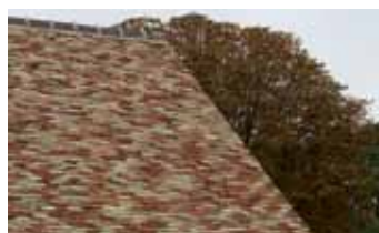
Toiture chamarrée par le mélange des tuiles
