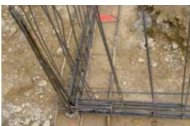
Nœud de chaînage - Continuité mécanique
