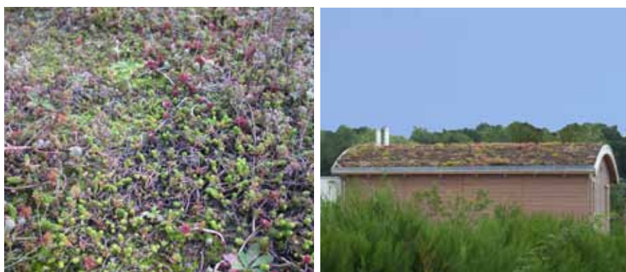
Toit végétalisé sur une maison d'habitation contemporaine.
