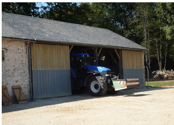
Des bâtiments agricoles inappropriés aux usages et utilisations contemporaines
