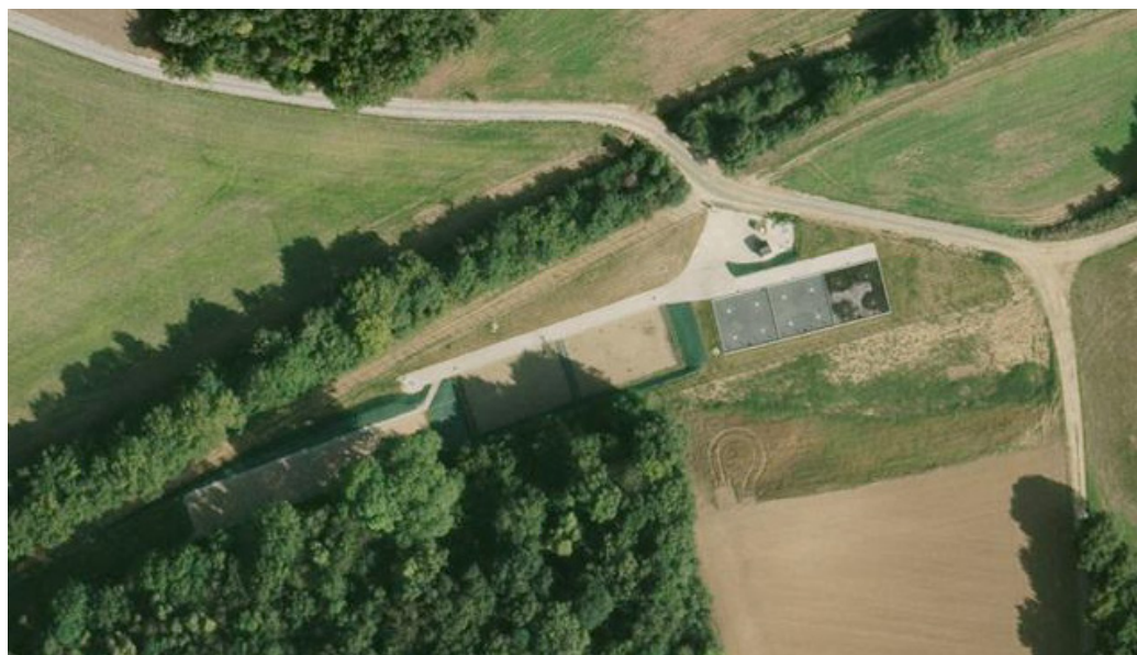
Le site de la station d'épuration
