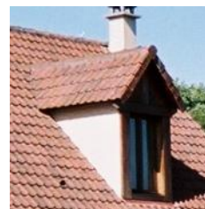
Lucarne à deux pans en bâtière sans rebord en façade
