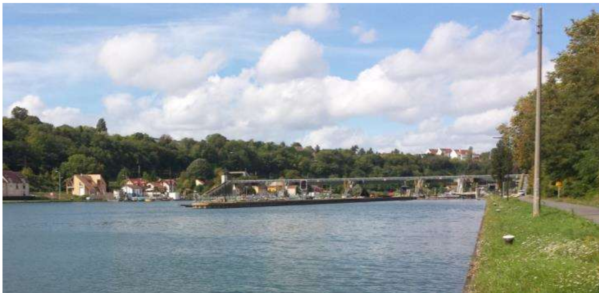
2 : Barrage de Coudray-Montceaux
