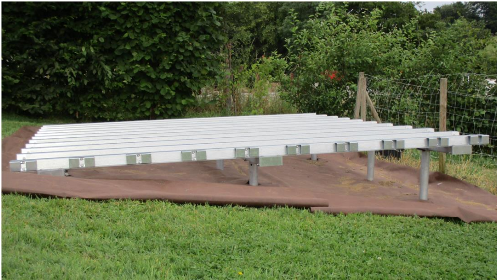
Pieux enterrés, permettant d'adapter l'abri à la pente naturelle du terrain. Très faible impact sur le sol et évite un terrassement préalable. Permet le passage de la petite faune et la circulation de l'eau.
