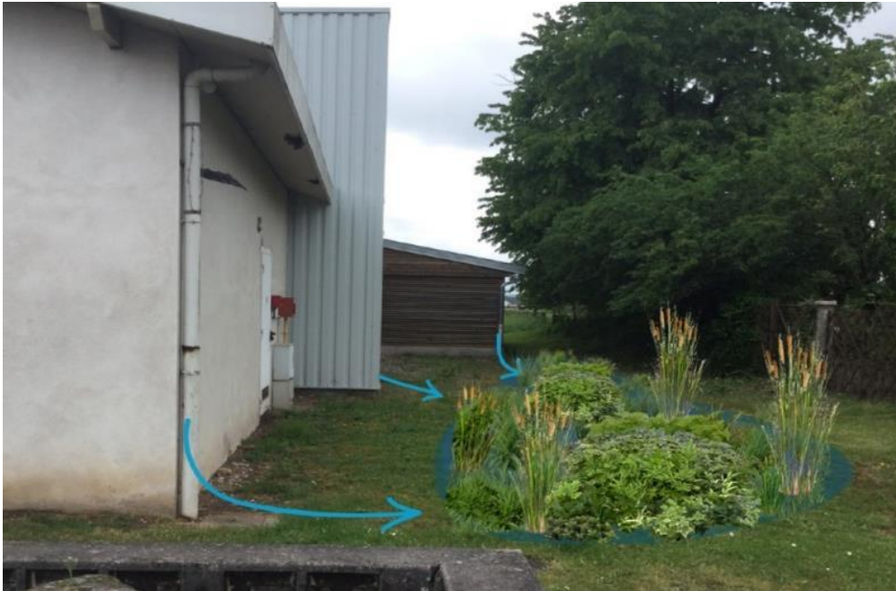
Le bâti existant, lorsqu'il s'accompagne d'un espace de pleine terre, peut aussi être adapté pour diriger les eaux des gouttières vers un bassin de pluie.
