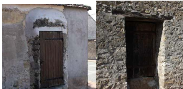
Puits Grande rue
