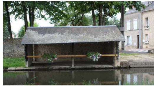
Lavoir rue des Ponts
