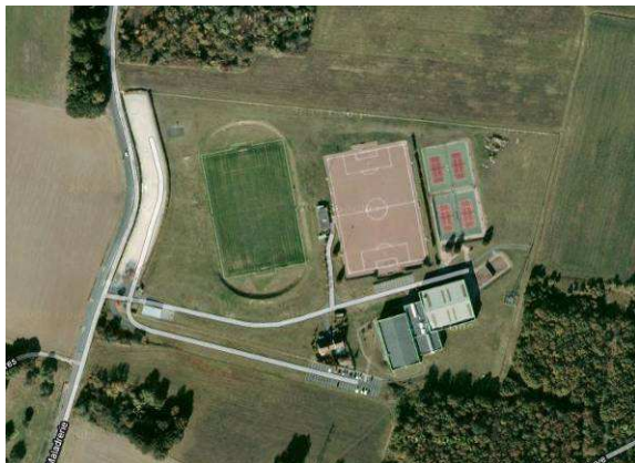
Vue aérienne du complexe sportif Jean Coulombel
