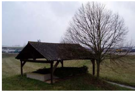
Four à chaux
