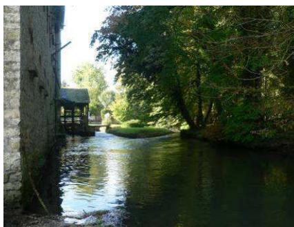
L'ancien moulin à eau de Brunehaut
