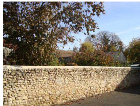
Mur en pierre
