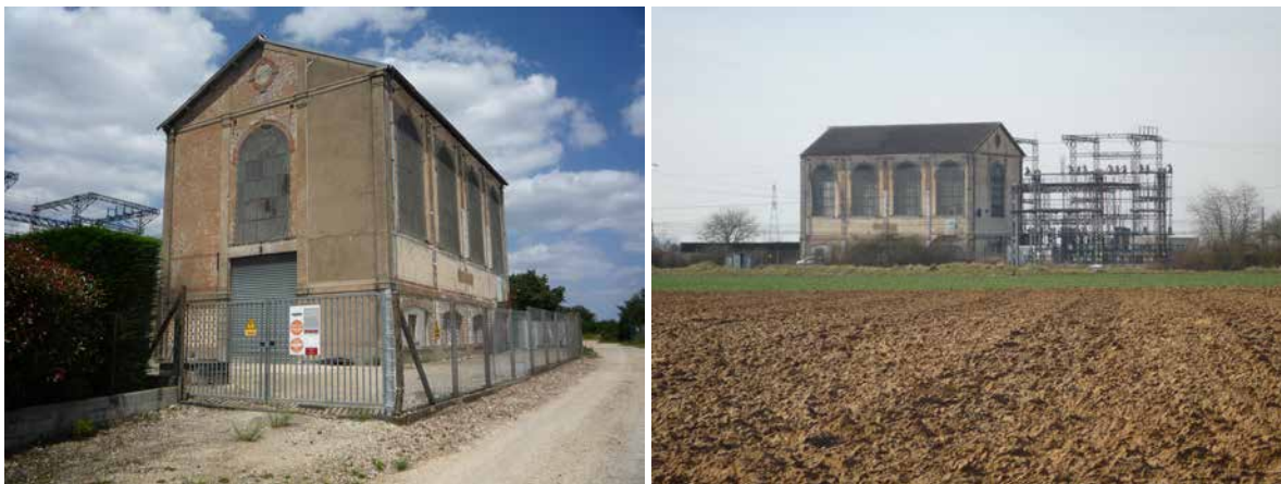
Le poste électrique de Thionville Source : Source : Jean-Pierre Denuc
