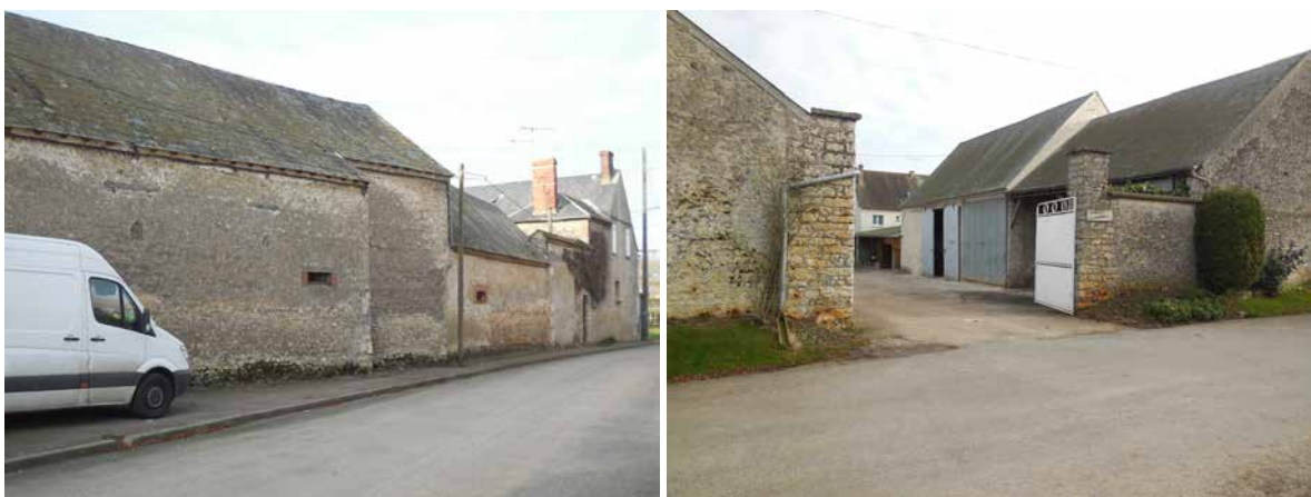
Des fermes implantées entre la rue principale et la rue du Tour du Village Nord
