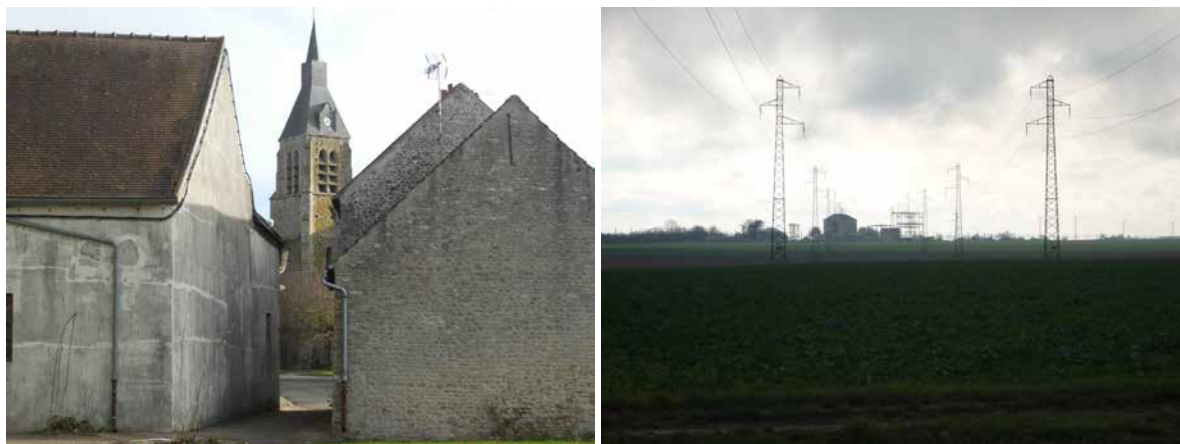
Le clocher de l'église et les lignes à haute tension Source : Source : Jean-Pierre Denuc
