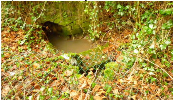
Passage d'eau souterrain
