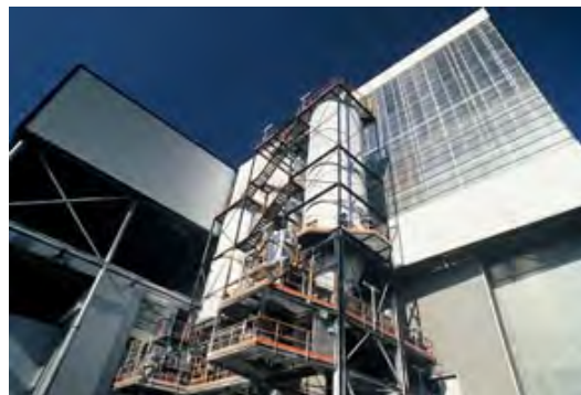
Unité d'incinération des ordures ménagères (UIOM) de Vert-le-Grand
