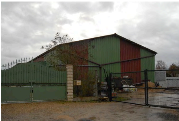
Hangar agricole en entrée de bourg nord-ouest
