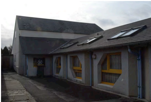
Extension récente de l'école
