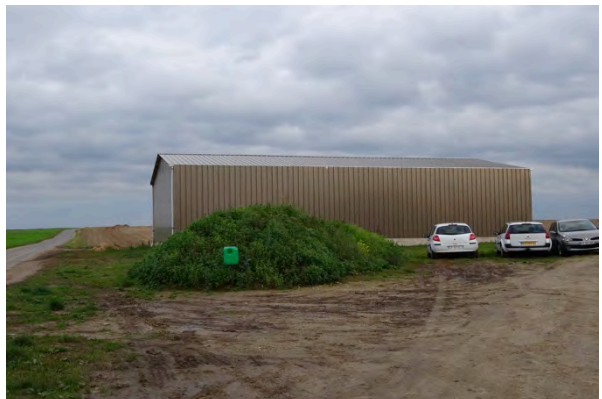
Hangar agricole en entrée de bourg est
