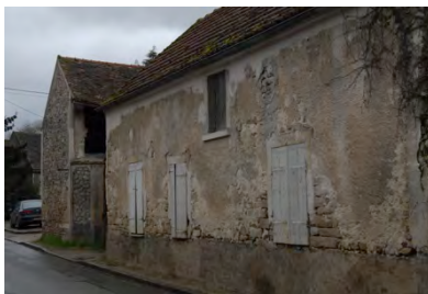
Alignement du mur gouttereau et du pignon
