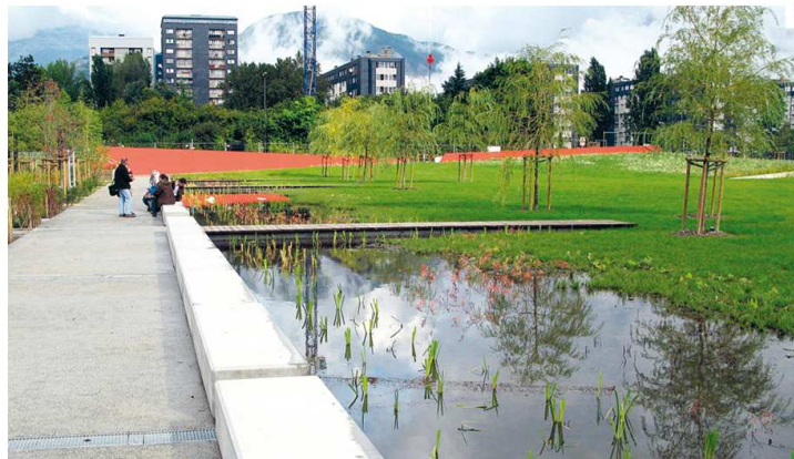
Bassin filtrant des eaux pluviales du parc Ouagadougou à Grenoble ( En attente image du PC de l'espace culturel)
