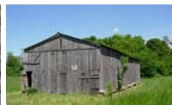
Ancien bâtiment agricole en bois
