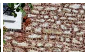
Ornementation en "rocaille" d'une façade en meulière
