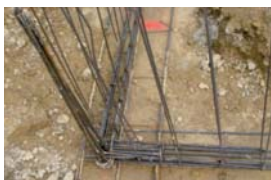
Nœud de chaînage - Continuité mécanique
