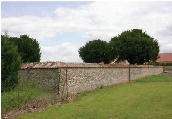
Mur du cimetière
