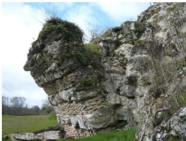
Fig 4. La culée nord du Pont des Ruines
