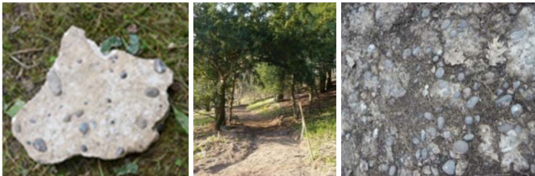
A gauche : échantillon de cailles (cliché D. Larpin). Au centre : vue d'ensemble d'allées décapées de terre végétale. Au centre : revêtement maçonné de l'allée après nettoyage fin
