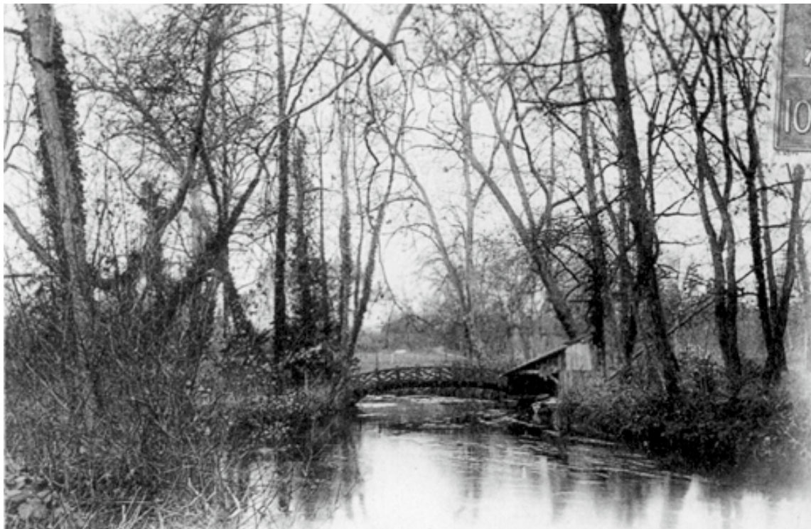
L'ancien pont cintré (pont aux boules d'or), SHACM
