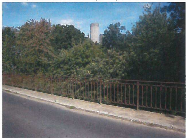
La tranchée envahie par la végétation [CG-01]
