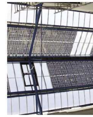
Les capteurs photovoltaïques sont intégrés à la verrière. © PIR Haute-Voie de Chevroux
