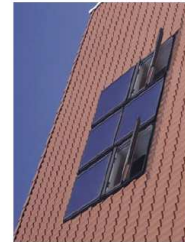
Quatre modules de capteurs thermiques et deux fenêtres sont installés sur un toit. © VELUX
