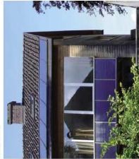
Les capteurs forment un bandeau horizontal qui prend appui sur la ligne d'égout du toit. © PIR Haute-Voie de Chevroux
