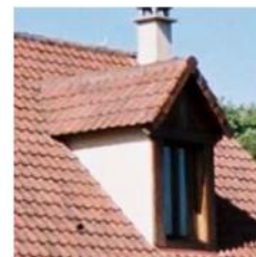
Lucarne à deux pans en bâtière sans rebord en façade « chien assis »
