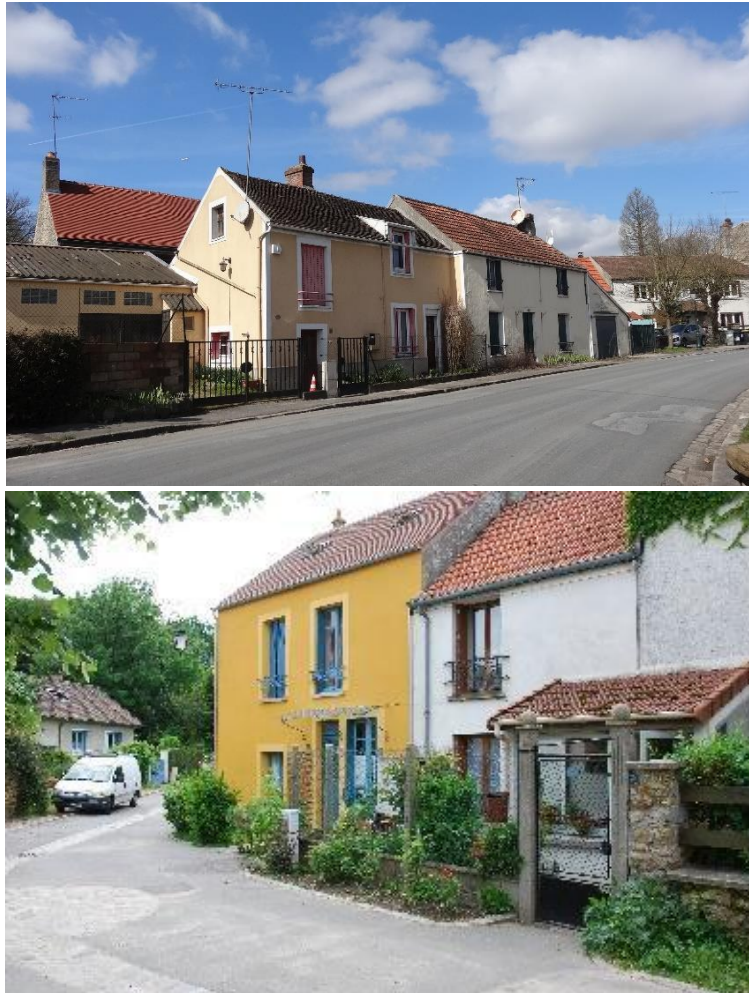
Ensemble de maisons rurales, 30-32 rue des Genévriers, 2-8 place de la Croix Verte, 2018 et 2008
