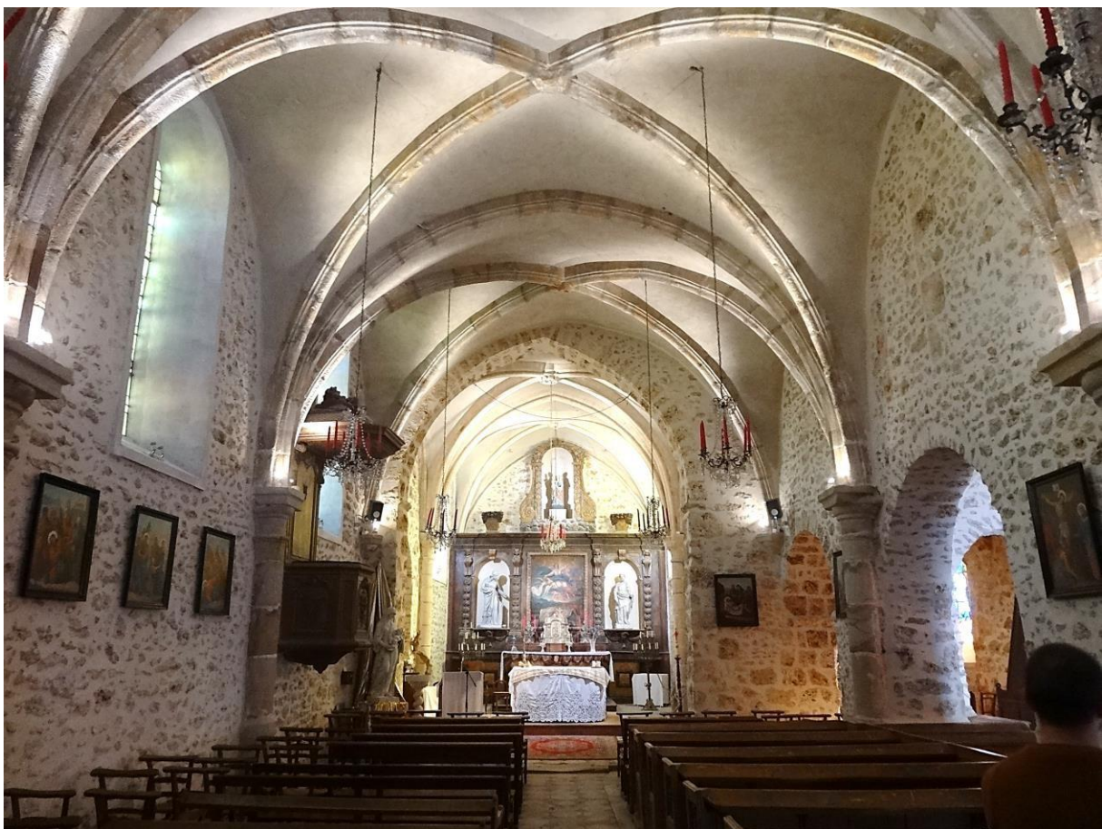
Eglise paroissiale, vue ouest (2012), vue intérieure (2018)
