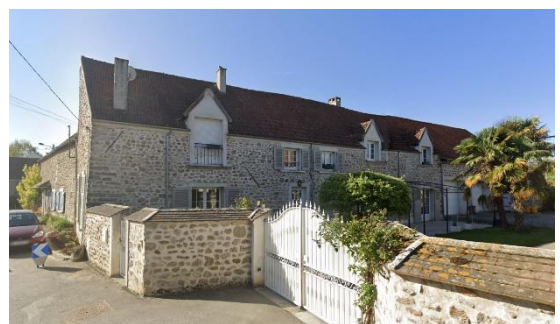
Lucarnes, situées sur la corniche du bâti Fortes pentes de toit - Arpenty
