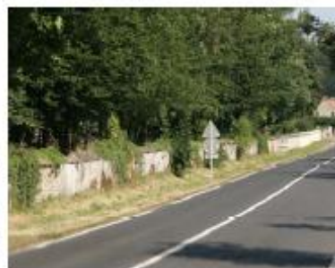
Mur de clôture, le long de la RD 97 face au Buisson Berthelot.
