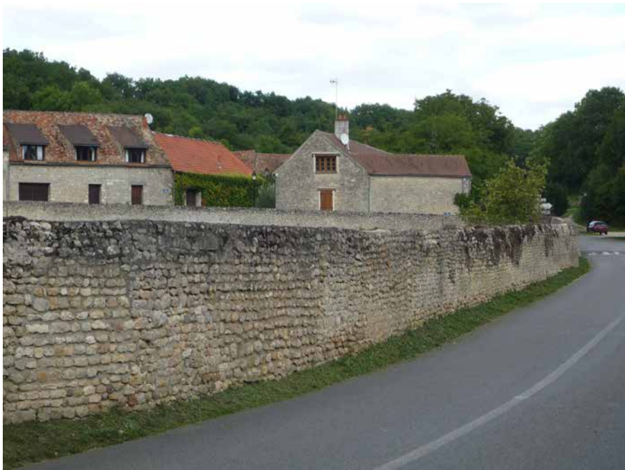
Source : photo J-P DENUC. LA RD 145 : une route dangereuse pour les piétons
