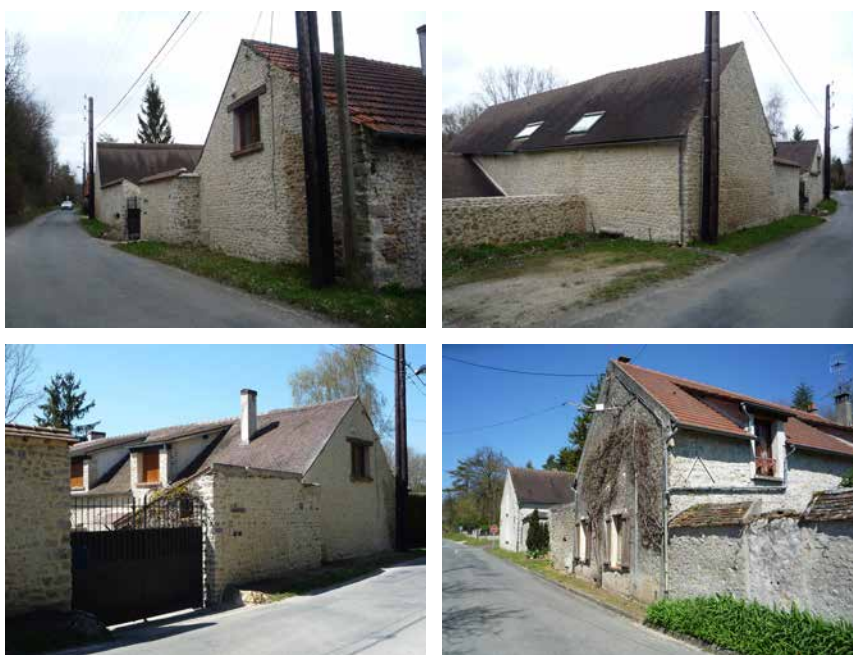
Source : Photos J-P DENUC. Dans les parties les plus anciennes, des constructions implantées à l'alignement
